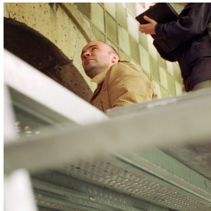
Bestandsaufnahme der Schäden des Nordturms
